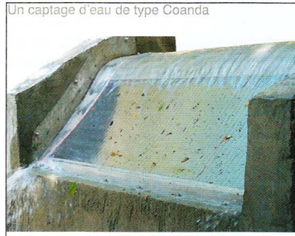
Un captage d'eau de type Coanda
